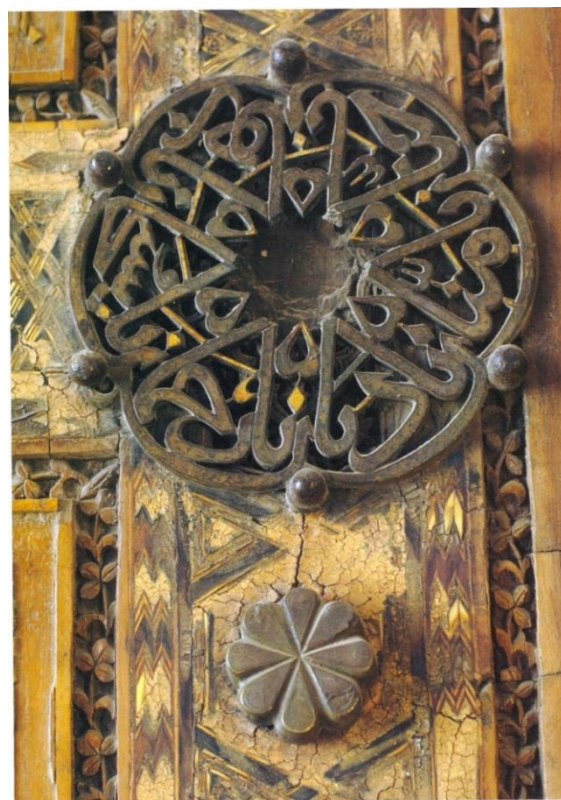
3-сурет – Қожа Ахмет Ясауи қабірханасы есігіндегі жоғалған тоқпақша орындары. Суреттен жұлынып алынған, зақымданған орындарын байқауға болады.
